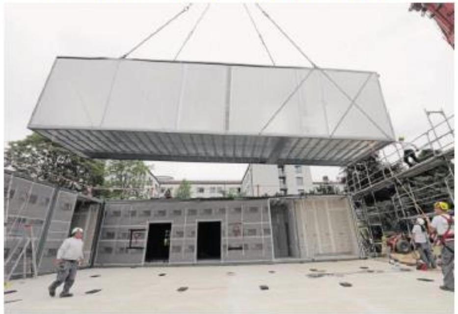
Ein Modul auf dem Weg an seinen endgültigen Standort. Später wird man nicht mehr erkennen, dass das OP-Zentrum aus 33 vorgefertigten Teilen zusammengesetzt wurde.
